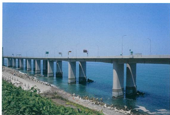
【脱塩工法 施工例】
