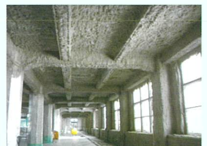
施工例 (建築物内部)
