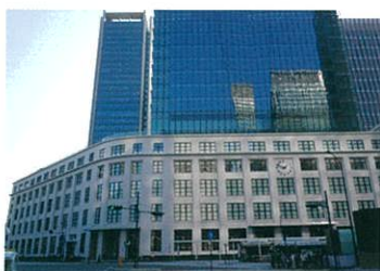
【再アルカリ化工法 施工例】
