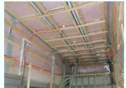
施工例 (橋梁上部工)
