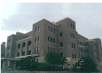
【再アルカリ化工法 施工例】
