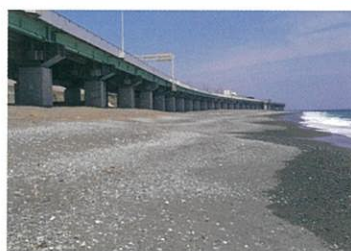
【脱塩工法 施工例】
