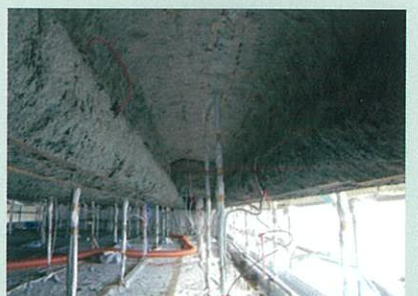
【床版・桁施工例】*通電中
