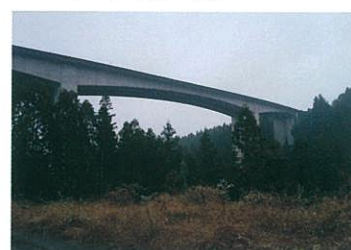
【脱塩工法 施工例】
