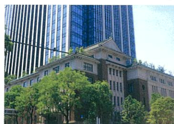
【再アルカリ化工法 施工例】
