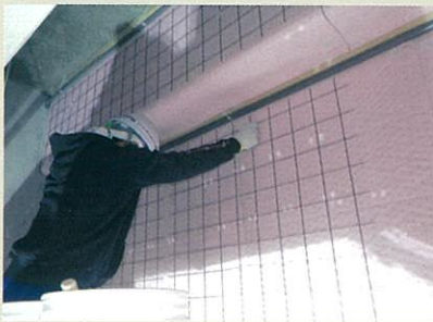
【保水マット・メッシュ設置状況例】
