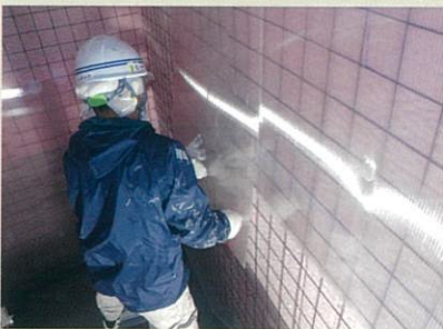
【ポリカーボネート板設置状況例】
