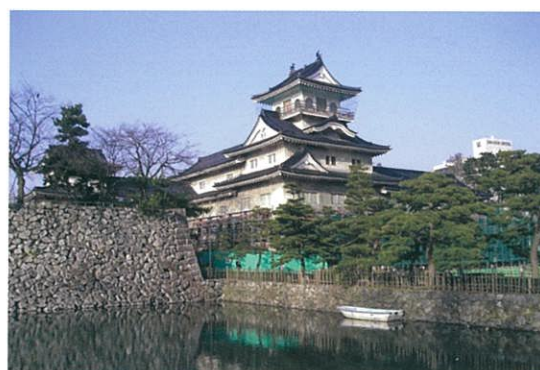
【再アルカリ化工法 施工例】
