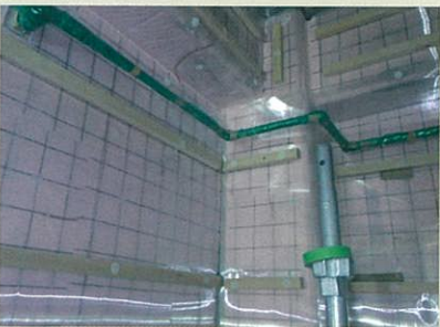
【壁・柱・梁施工例】*通電中
